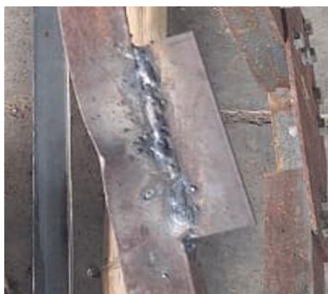
Gambar 3. Perbaikan dengan cara Penebalan Profil
