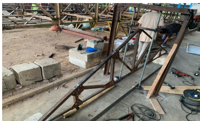
Gambar 4. Perbaikan dengan Penggantian Profil
