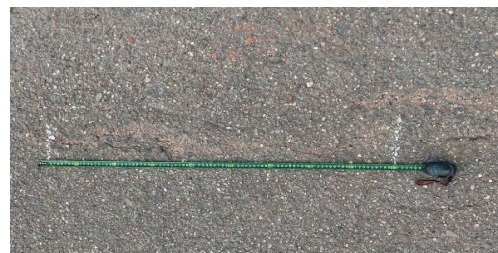
(b) Pengukuran panjang/lebar kerusakan menggunakan meteran
