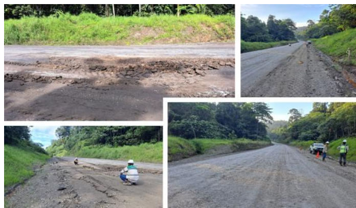
Gambar 3. Pengukuran jalan hauling segmen 4 (KM 42+200) sebelum dilakukan perbaikan.
