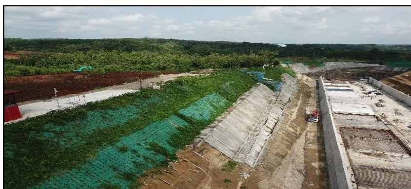
Gambar 2. Pengaplikasian Metode Geomat dan Shotcrete
