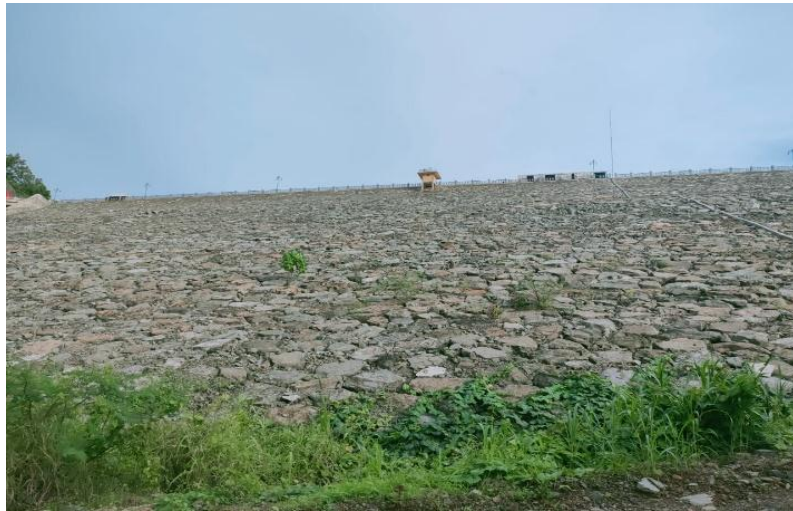
Gambar 4. Foto kondisi rumput pada kaki lereng hilir bendungan Tapin (BWS Kalimantan III, 2021)
