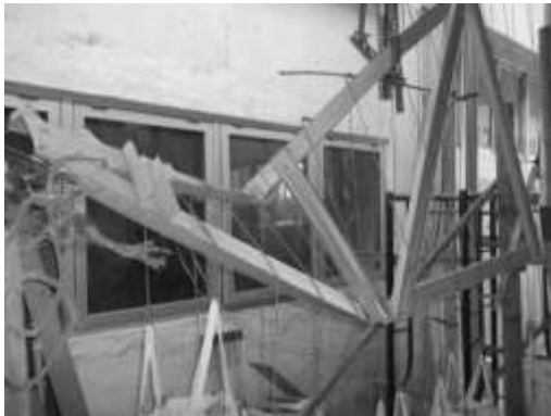
a. Kegagalan tekuk pada batang tekan rangka kuda-kuda baja
