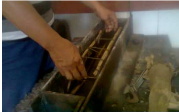
Gambar 4. Pemasangan Tulangan Komposit Benda Uji Balok
