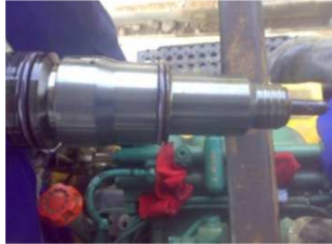
Gambar 7. Unit injector pada copper sleeve yang tidak rusak
