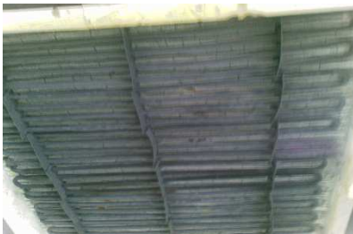
Gambar 6. Heater setelah diganti
