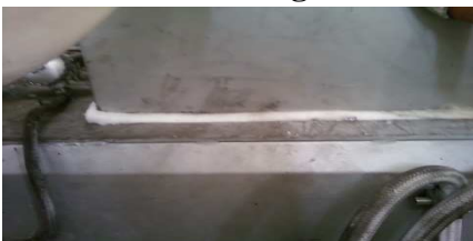
Gambar 12. Blanket setelah diganti
