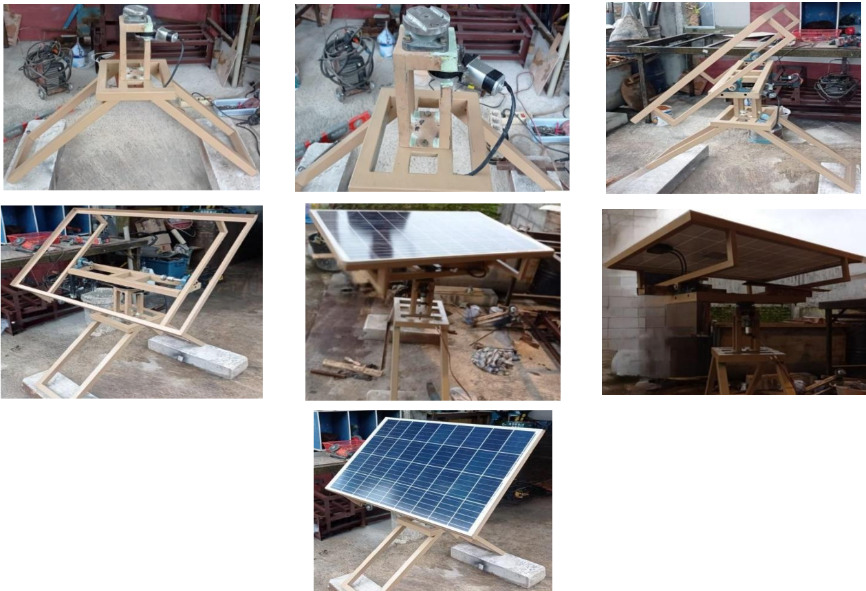
Gambar 10. Fabrikasi dan assembly konstruksi portable solar tracker
