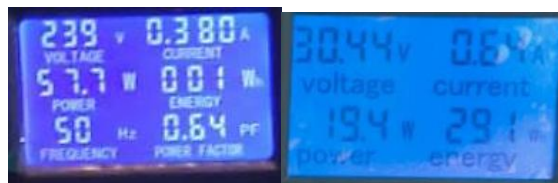
Gambar 5 Power Meter PLN dan PLTS
