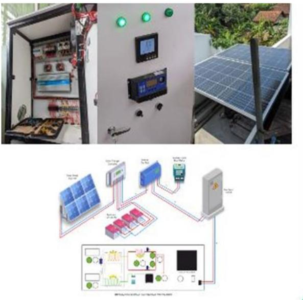
**Gambar 1.** Rancang Bangun PLTS Sistem Hybrid Kapasitas 400 WP Berbasis PLC Dan SCADA Pada Mesin Pengering Daun Teh Untuk Mengurangi Pemakaian Daya PLN (sumber :syahid,2023)
