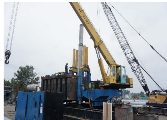
Gambar 8. Pelaksanaan pemancangan di Proyek Pembangunan Rumah Susun Mahasiswa PPU
