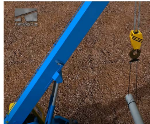
Gambar 3. Ilustrasi Pengangkatan Tiang Pancang (Jack Xie (T-Works), 2013)
