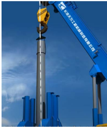
Gambar 6. Ilustrasi Pemeriksaan Vertikalitas (Jack Xie (T-Works), 2013)
