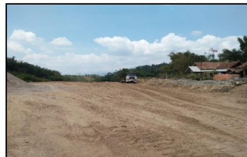
Gambar 6. Kondisi Eksisting Disposol yang Dekat dengan Pemukiman Warga
