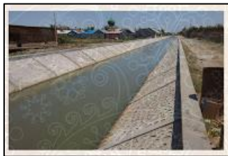
Gambar 11: Drainase Jalan Type Trapesium Sumber : (Konsultan Teknik 2014)
