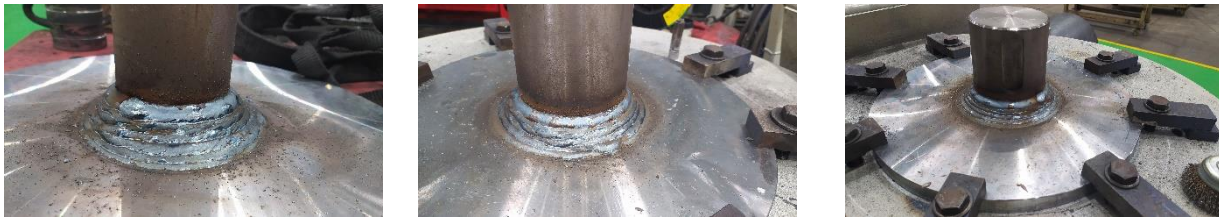
Gambar 7. Hasil Pengelasan Stub Shaft Menggunakan Alat Welding Rotary Table
