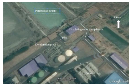
Gambar 1. Lokasi ECP pada PLTU Rembang
