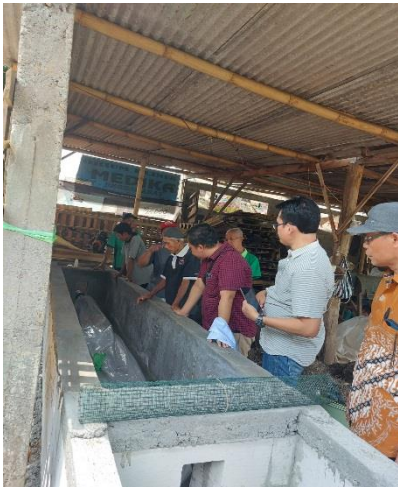
Gambar 4. Bak penampung biodigester
