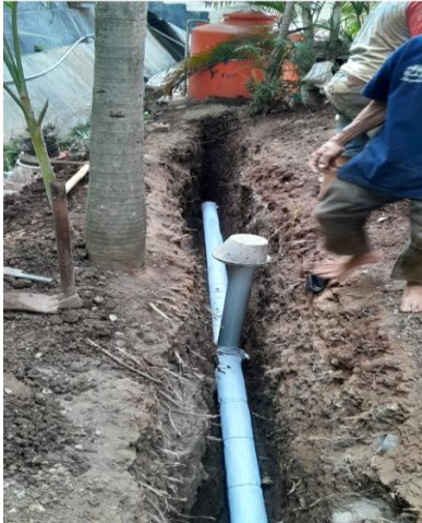
Gambar 2. Pemasangan Pipa Resapan Horizontal didalam tanah
