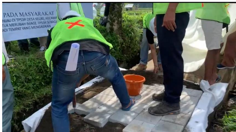
Gambar 7. Cara Memasang Paving Terintegrasi dengan Geotextile
