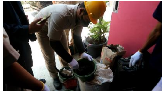
Gambar 10. Pembuatan Adukan Plesteran
