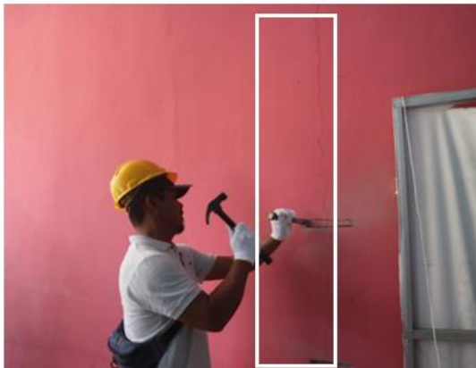
Gambar 8. Membuat Celah di Dinding
