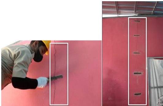
Gambar 12. Hasil dari Perbaikan Dinding Retak Menggunakan Metode Jahitan
