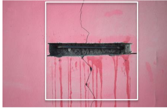
Gambar 9. Besi Dipasang di dalam Celah Dinding
