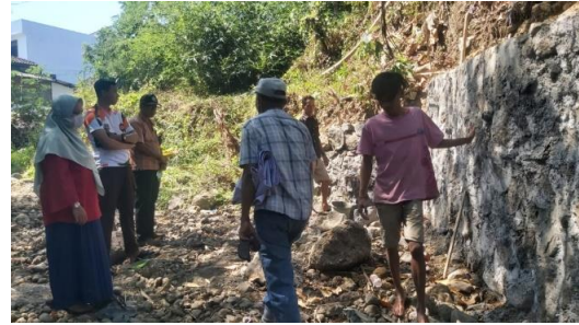
Gambar 6. Pemeriksaan Perbaikan dan Perkuatan Dinding Penahan Tanah
