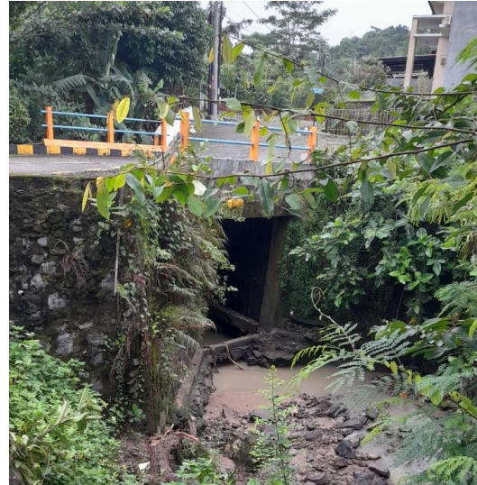
Gambar 2. Kondisi Jembatan Sebelum Perbaikan
