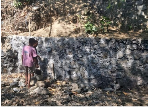
Gambar 4. Proses Perbaikan Dinding Penahan Tanah di Sekitar Lokasi Jembatan
