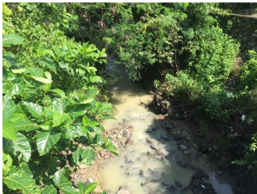
Gambar 1. Aliran Sungai di Sekitar Jembatan
