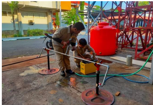
Gambar 4. Proses Uji Tekan Instalasi Pipa Galvanis
