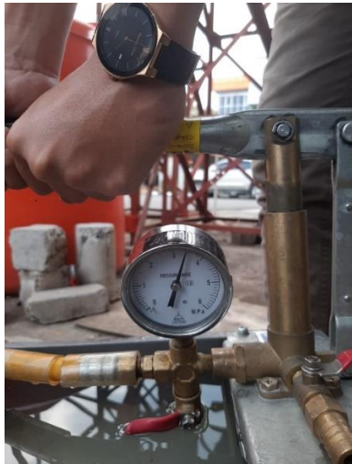
Gambar 17. Hasil uji tekan pada instalasi pipa bocor diperbaiki menggunakan las
