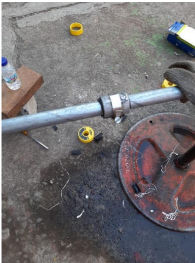
Gambar 11. Pemasangan clamp pipa pada badan pipa
