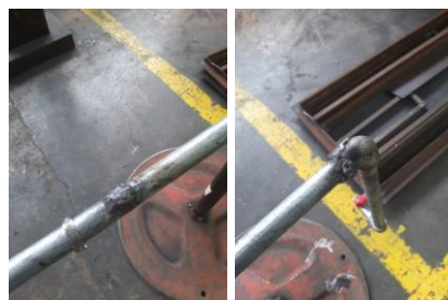
Gambar 16. Perbaikan instalasi pipa bocor menggunakan las
