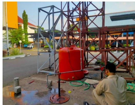
Gambar 5. Pemeriksaan Debit Instalasi Pipa Galvanis
