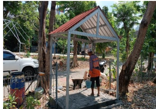
Gambar 6. pembangunan rumah pilah sampah
