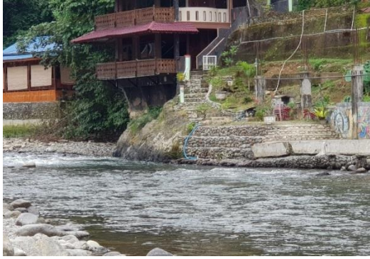
Gambar 6. Kondisi daerah aliran sungai yang akan menggerus bagian bangunan di sekitar daerah pengabdian.
