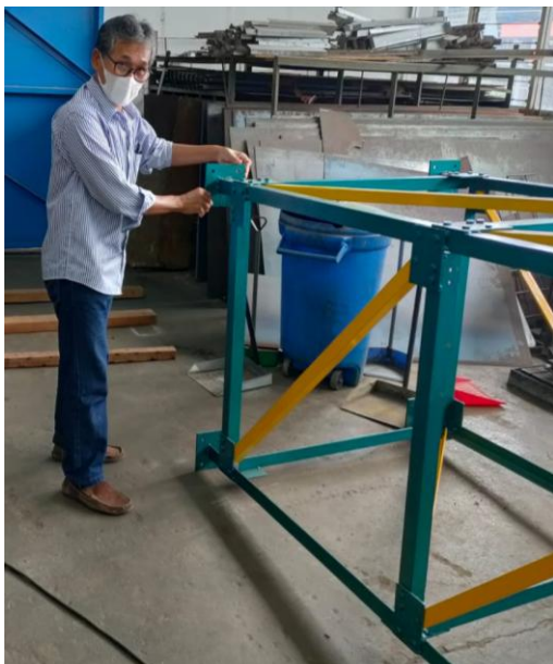
Foto 10. anggota tim dengan tower yang terpasang baseplate dan plat siku
