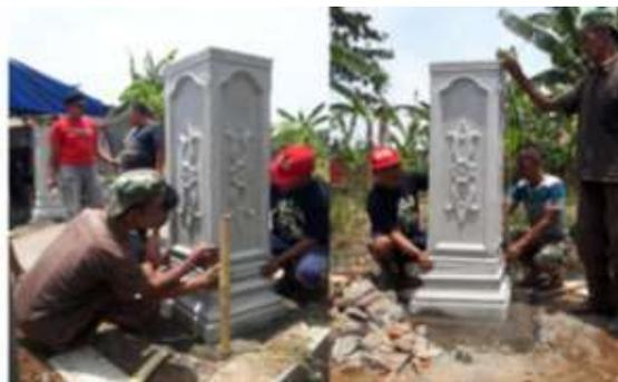
Gambar 4. Perakitan dan Pemasangan Cetakan Gapura
