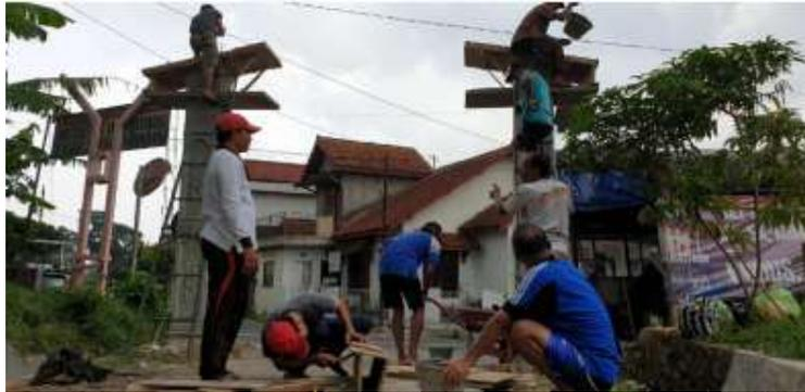
Gambar 6. Proses Pengecoran Cetakan Gapura
