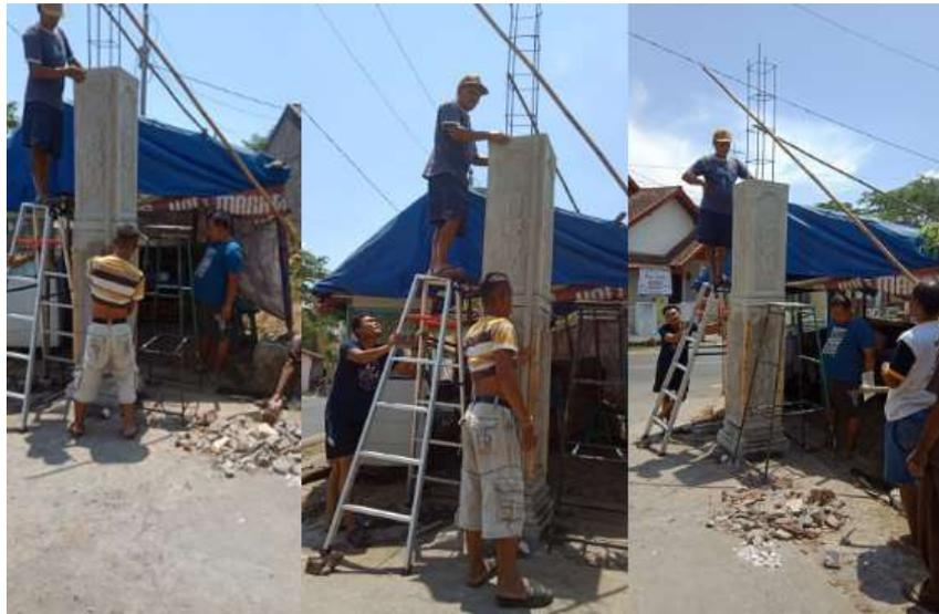
Gambar 7. Pemasangan besi beton pada cetakan atas
