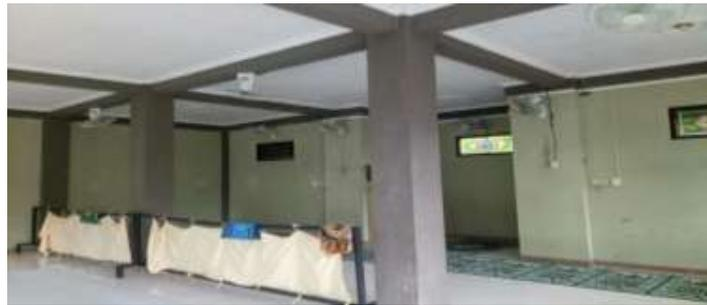
Foto 2 Musholla Baitut Taqwa tampak bagian dalam (lubang void penghubung lantai 1 & 2 di ruang sekitar pengimaman masih ditutup plafon, dan di atasnya ditutup atap asbes)
