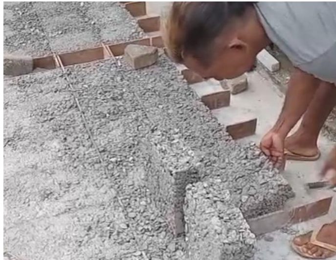
Gambar 1. Pelepasan Beton dari Acuan
