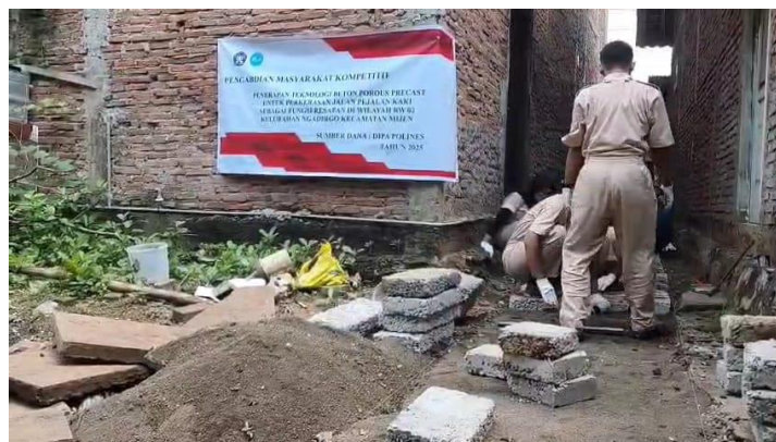
Gambar 5. Penyambungan dan Perataan Permukaan
