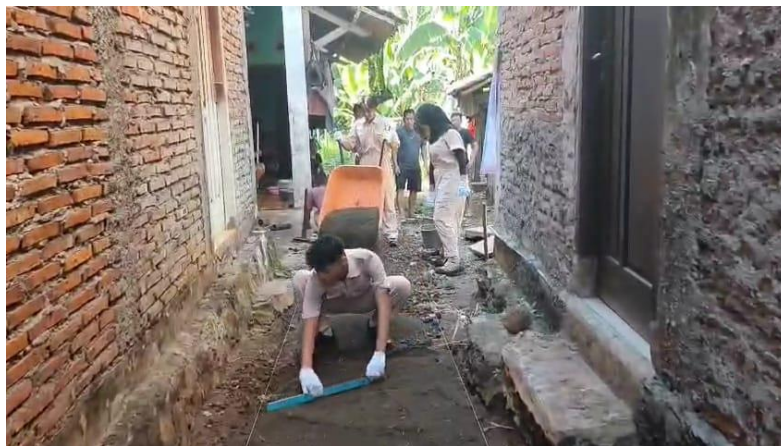
Gambar 3. Perataan Lapisan Pasir Alas ( Bedding Layer )
