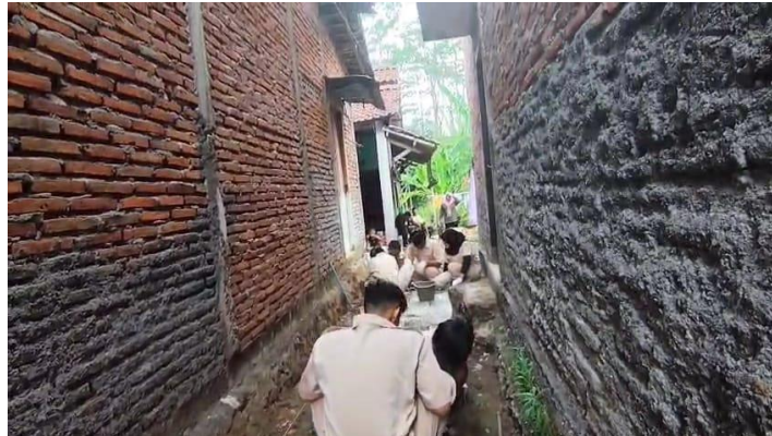
Gambar 3. Pemasangan Elemen Beton Porous Precast
