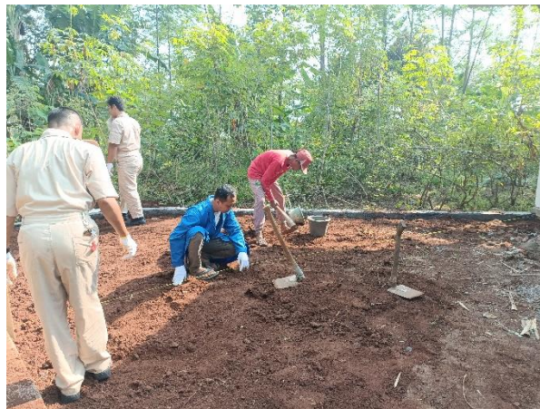
Gambar 2. Perataan Tanah Dasar
