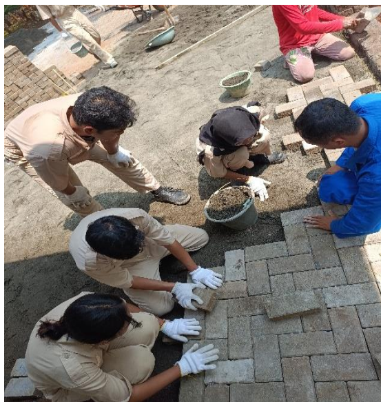
Gambar 4. Pemasangan Paving Block
