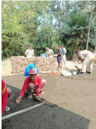
Gambar 3. Pemasangan Lapisan Pasir Alas
