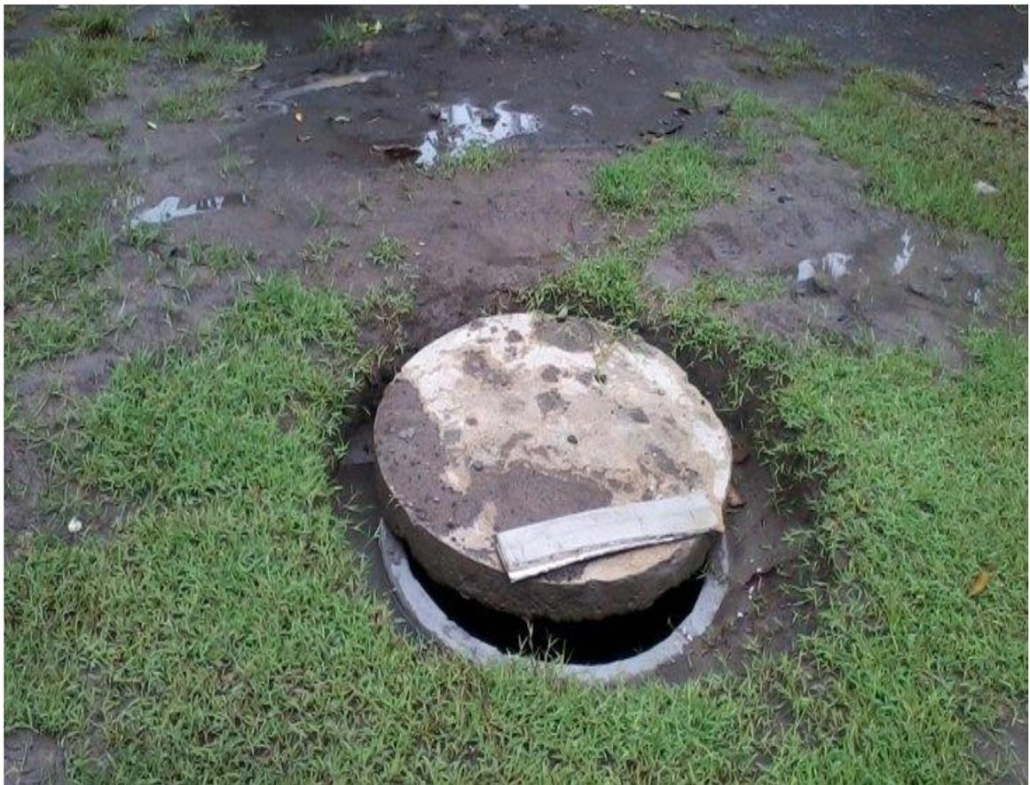
Gambar 4 Konstruksi penutup Sumur resapan dengan bahan cor beton
