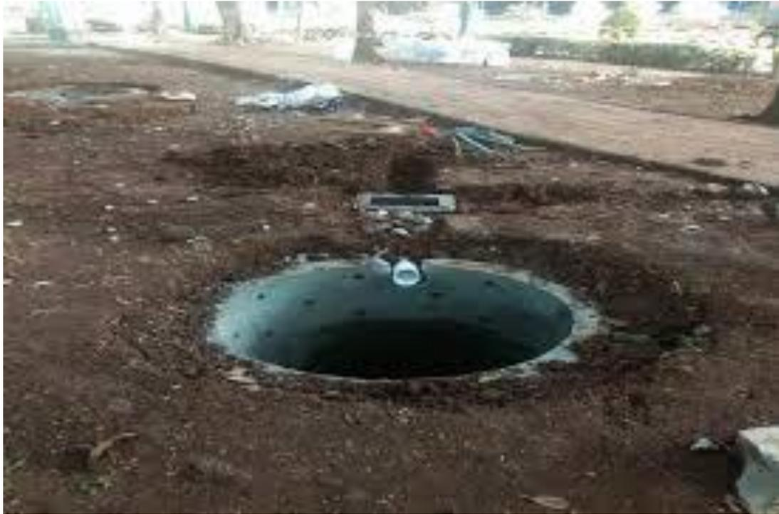
Gambar 3 Konstruksi Sumur resapan dengan bahan buis beton
