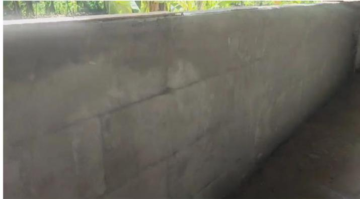
Gambar 6. Hasil plesteran mortar instant pada bata ringan
