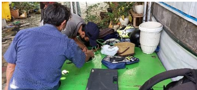
Gambar 3 Proses Instalasi Bagian Kontrol
