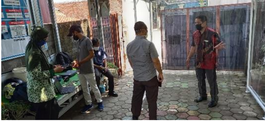
Gambar 4 Proses Instalasi Alat
