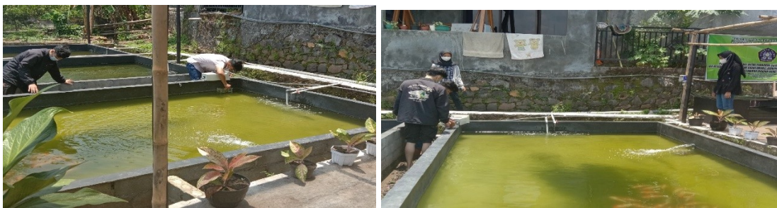
Gambar 2a. Foto saat pemasangan alat di Kolam Budidaya Ikan Koi
