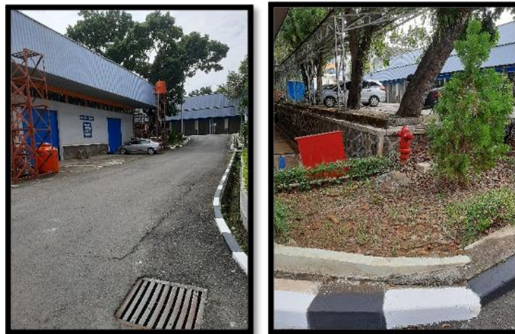
Gambar 6. Jalan Lingkungan dan Hidran halaman
