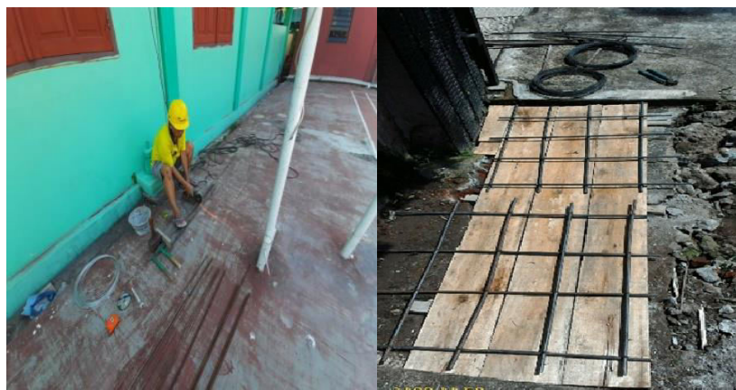
Gambar 4. Pemotongan dan Perakitan Tulangan Penutup Saluran
