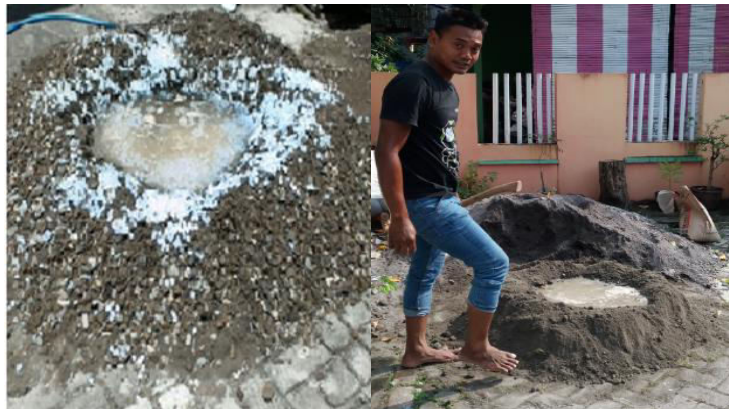
Gambar 6. Persiapan adukan beton ditambah agregat plastik untuk pengecoran
