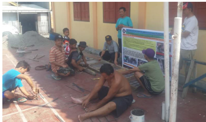
Gambar 5. Perakitan Cetakan Dan Penulangan Plat Tutup Saluran
