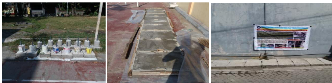
Gambar 8. Hasil Cor Penutup Saluran diluar dan Blok Tiang Bendera
