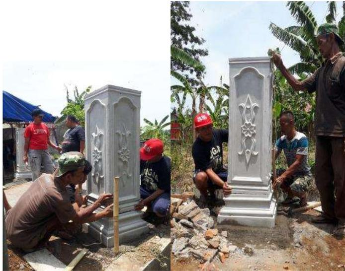
Gambar 4. Perakitan dan Pemasangan Cetakan Gapura
