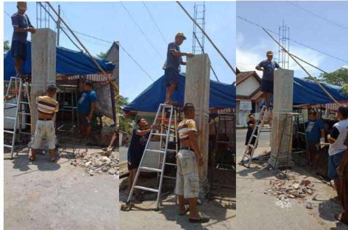
Gambar 9. Pemasangan besi beton pada cetakan atas
