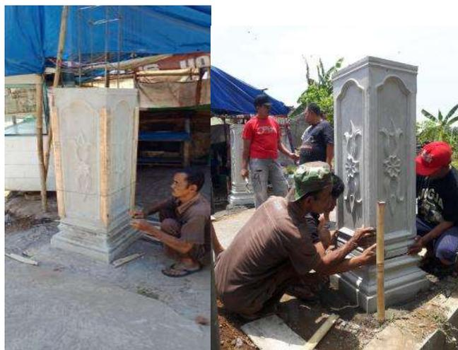
Gambar 5. Pelurusan pemasangan Pree Cast
