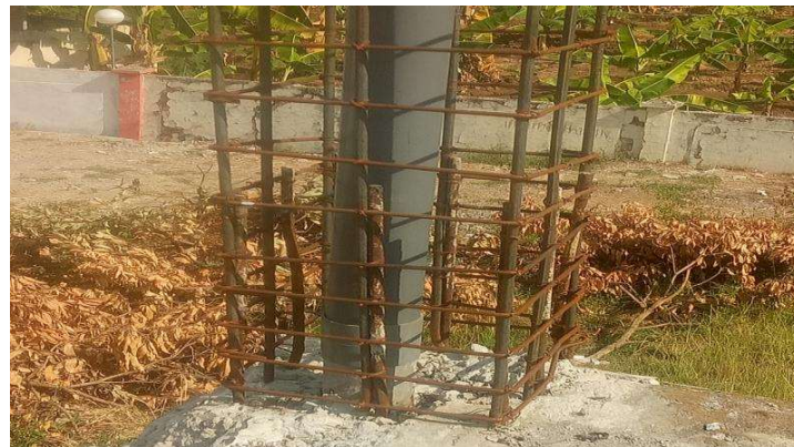
Foto 6. Penyambungan tulangan kolom atas dengan kolom bawahnya
