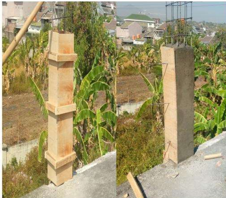
Foto 8. Pemasangan cetakan Kolom struktur dan Kolom struktur yg sudah dicor
