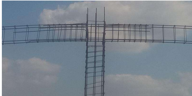
Foto 4. Penyambungan ujung tulangan kolom dengan balok
