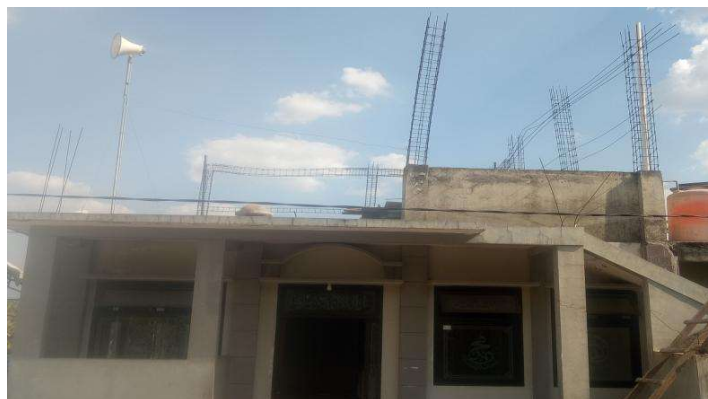
Foto 9. Penampakan musholla yang telah dipasang balok pada kolom
