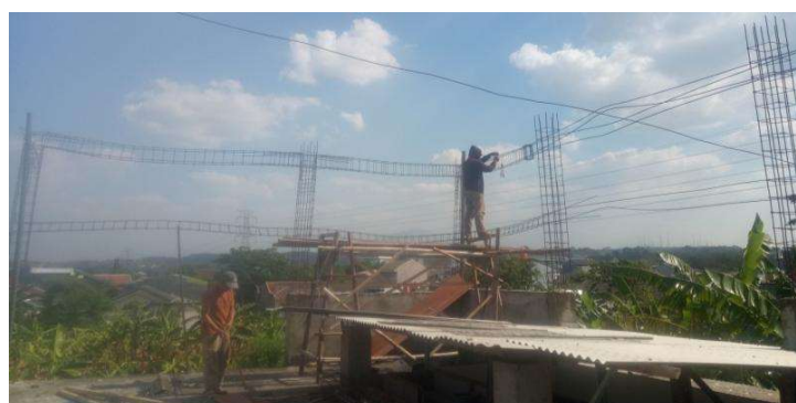
Foto 3. Perakitan Tulangan Balok Struktur , Kolom Struktur , dan Balok Latei
