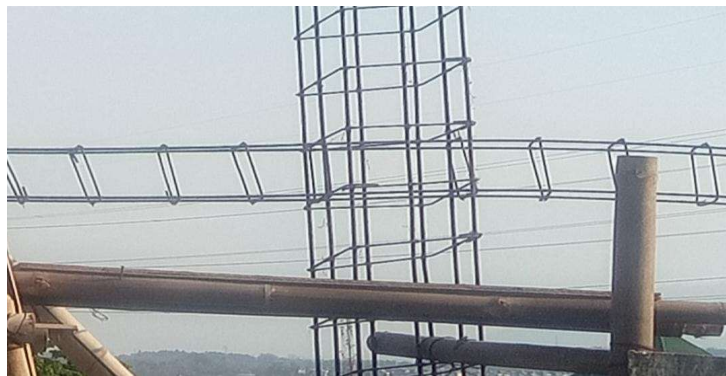
Foto 5. Pembuatan balok latei diatas kusen untuk memperkuat ketahanan dinding terhadap gempa
