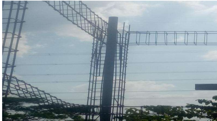
Foto 7. Penyambungan tulangan kolom dan balok di sudut bangunan
