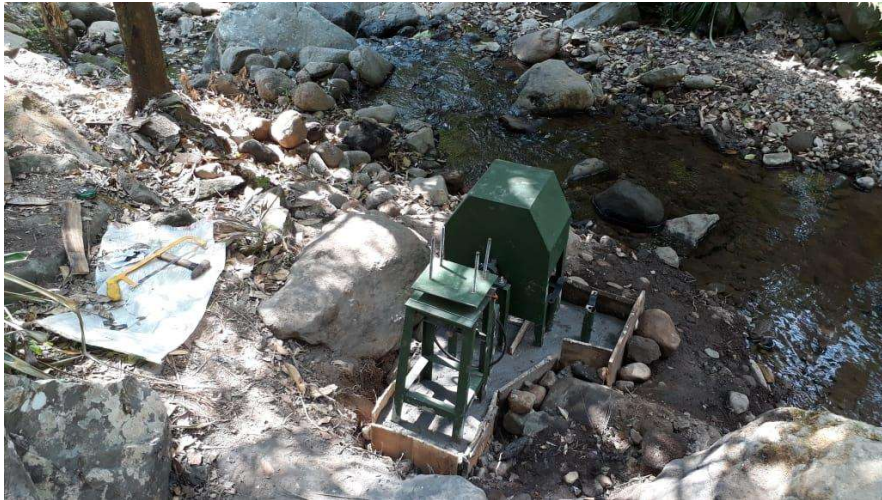
Gambar 5.5. pemasangan turbin pelton
