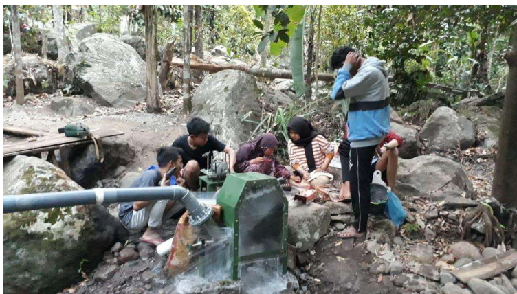
Gambar 5.6. pemasangan turbin pelton
