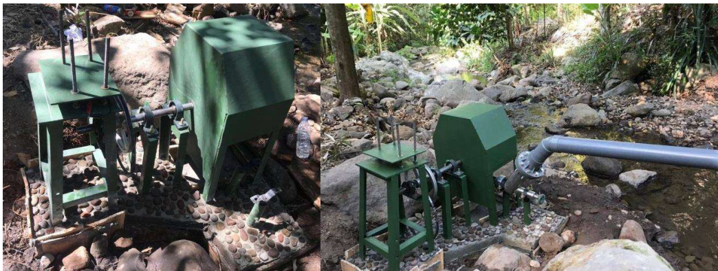
Gambar 5.6. pemasangan turbin pelton
