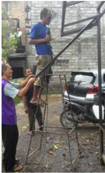
Gambar 3. Pemasangan frame di pos kamling
