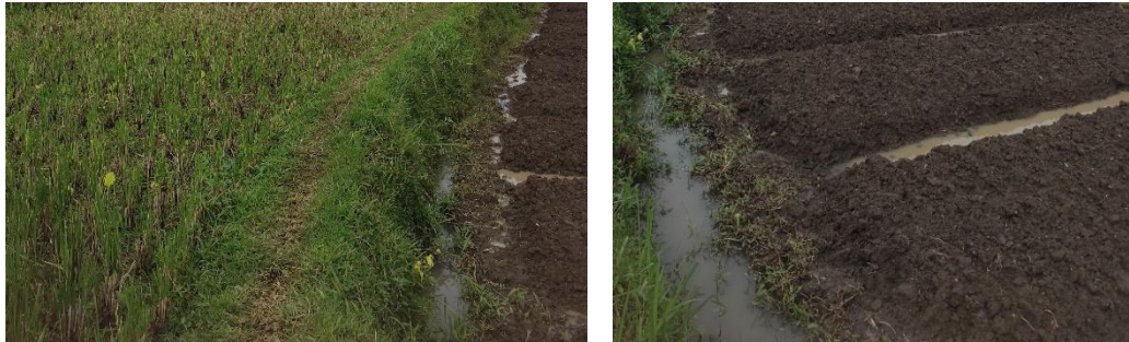
Gambar 4. Kondisi Eksisting Desa Baran
