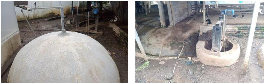
Gambar 1. Pengolahan biogas PT Lumpang Semar Sejahtera
