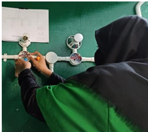
Gambar. 4 Instalasi Lampu
