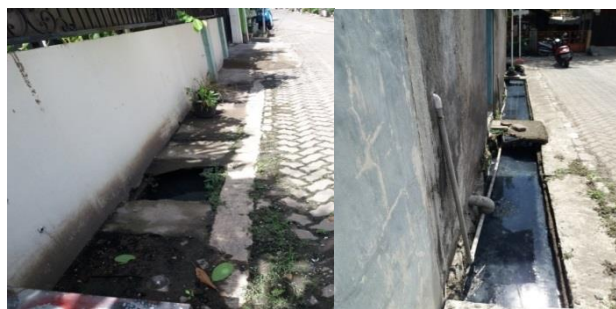
Gambar 1. Kondisi Lokasi Aplikasi Rencana ditutup Plat Beton Plastik
