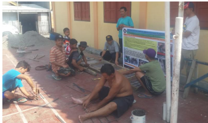
Gambar 5. Perakitan Cetakan Dan Penulangan Plat Tutup Saluran
