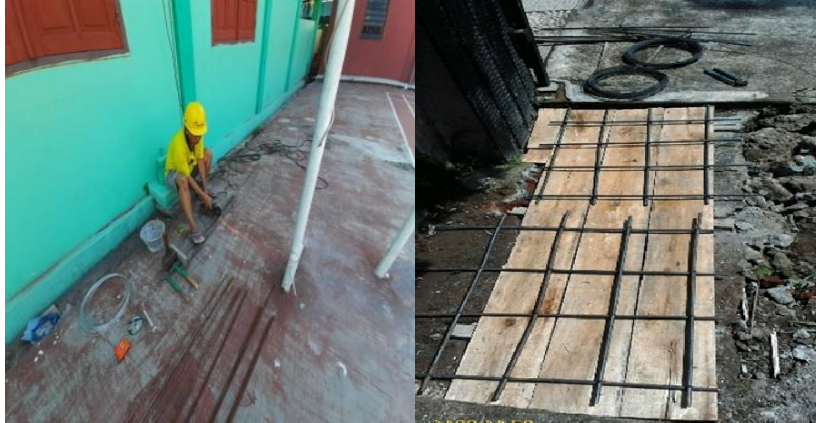
Gambar 4. Pemotongan dan Perakitan Tulangan Penutup Saluran
